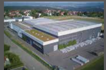
Hugo Brennenstuhl GmbH & Co. KG Stammsitz/Headquarter Werk 2 🇩🇪 Tübingen Deutschland / Germany
